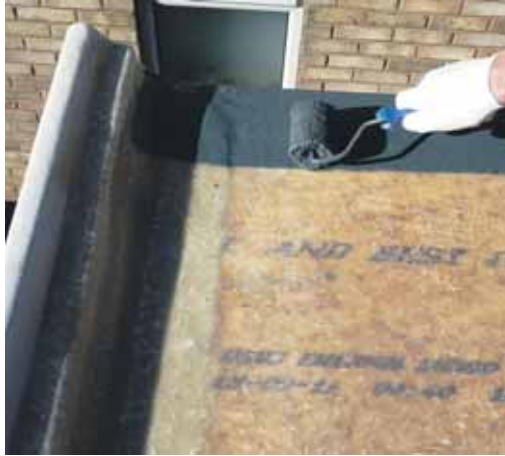
Top edge onto deck
